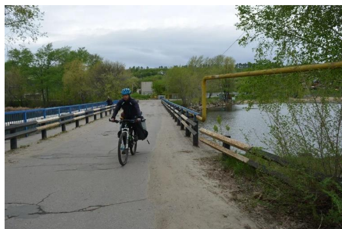
40.Конец ПП (мост через р Тушенка)
