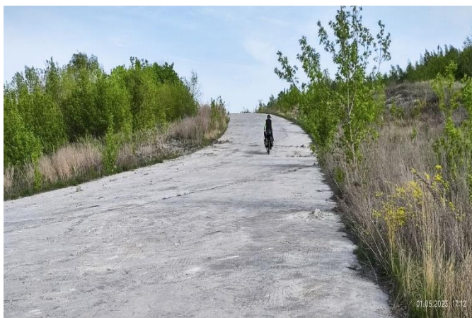
33.Бетон х/к (Цемзавод) 2
