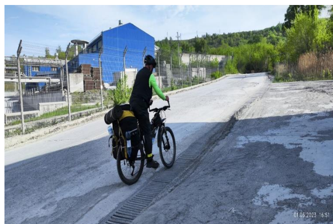
30.Бетон х/к (Цемзавод)
