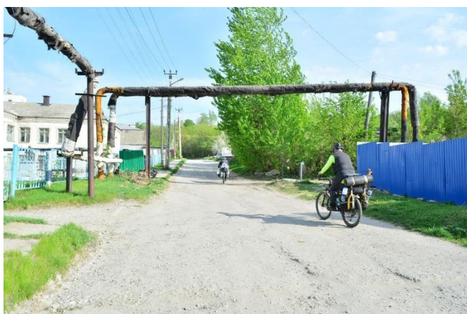
29.Бетон х/к (Цемзавод)
