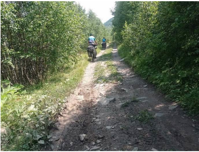
фото 13 Грунт, дорога разбитая, сух.
