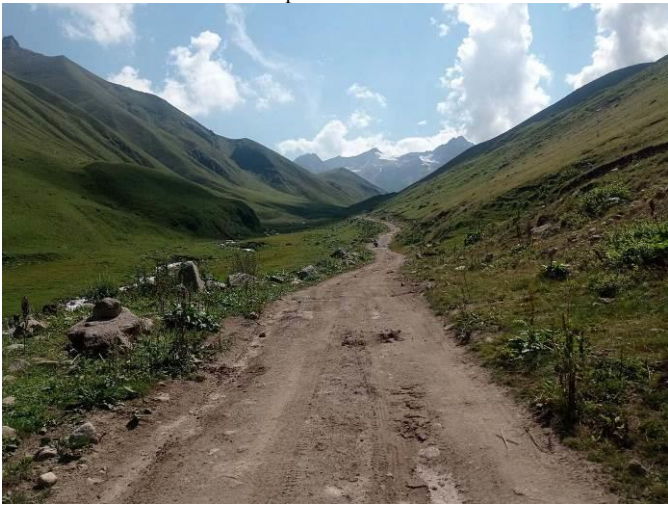
фото 21 Грунт, дорога разбитая, сух.
