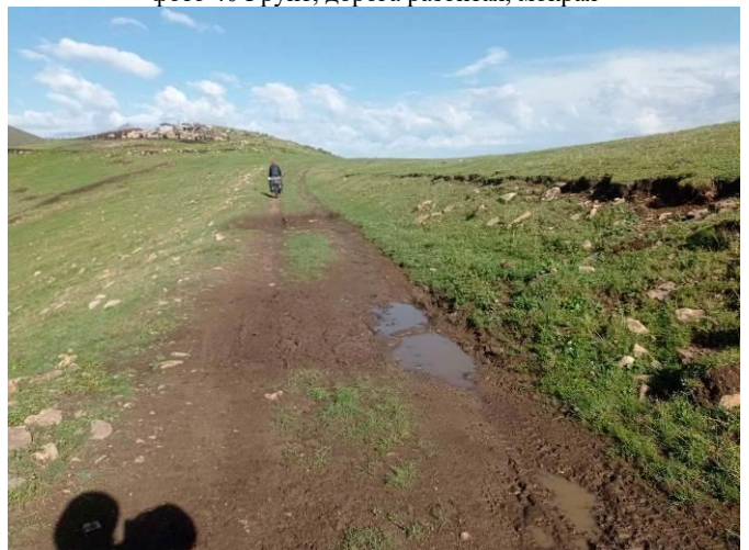
фото 42 Грунт, дорога разбитая, мокрая
