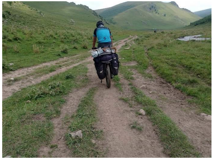
фото 22 Грунт, дорога разбитая, сух.
