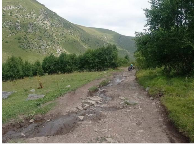
фото 16 Грунт, дорога разбитая, сух.
