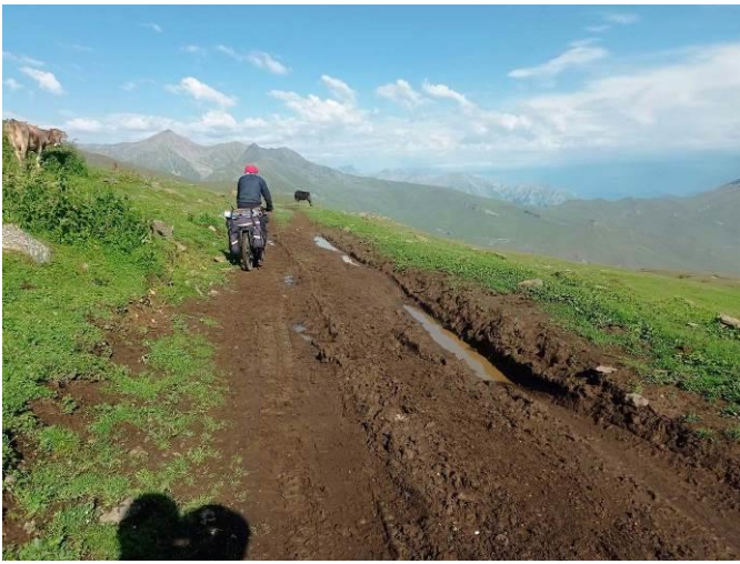
фото 43 Грунт, дорога разбитая, мокрая
